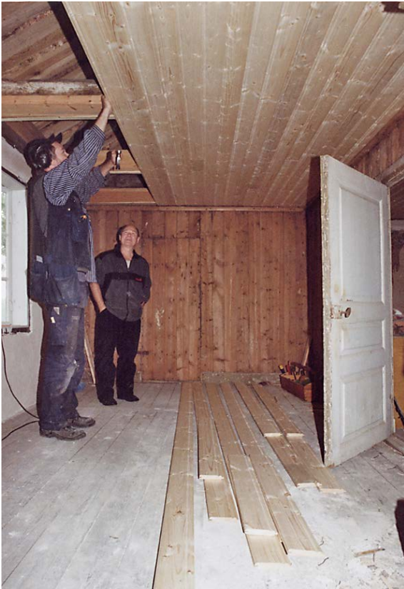
Vänster: Mattias Forsberg monterar nytt tak av pärlspånt i köket. Lasse Dahlberg övervakar. Okt. -06. Höger: Kökets yttervägg kalkputsades och fönsterfoder monterades. Nov. -06.
